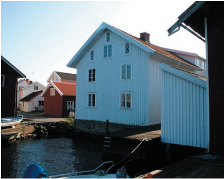
Bremerska huset, en av Klädesholmens kulturhistoriskt värdefulla byggnader. Byggnaden är mycket uppskattad av de bodende på Klädesholmen.
